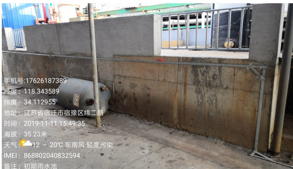
图 4.2-2 初期雨水收集池照片
